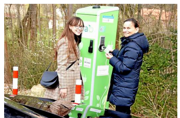
So einfach geht das: Nancy Hartmann (links) und Sandra Proft von der Energieversorgung Apolda führten vor, wie die neue E-Ladesäule Am Lachenweg Bad Sulza funktioniert. DIRK LORENZ-BAUER
