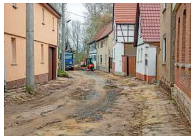
Für die Arbeiten am Abwasser- und am Stromnetz wird die Obergasse in Auerstedt komplett aufgerissen. MARTIN KAPPEL
