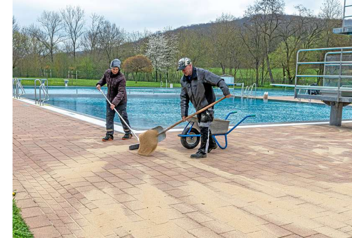
Zur Saison-Vorbereitung gehört auch das Abkärchern der Pflastersteine sowie das Einkehren des neuen Sandes. Damit sind Schwimmmeisterin Sandy Krug und Silvio Veit gerade beschäftigt. MARTIN KAPPEL
